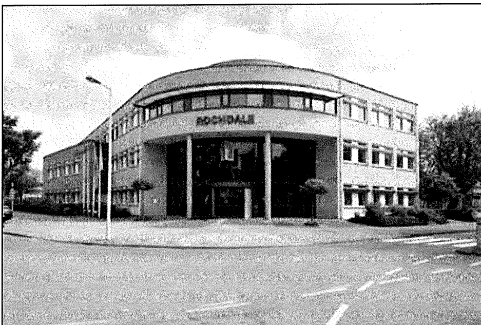
Afbeelding: Bestaand kantoorpand aan de Slotermeerlaan 152
